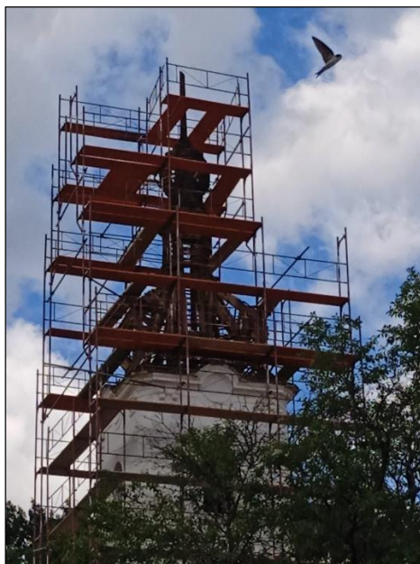
A felállványozott, régi bádogfedéstől már megfosztott harangtorony
